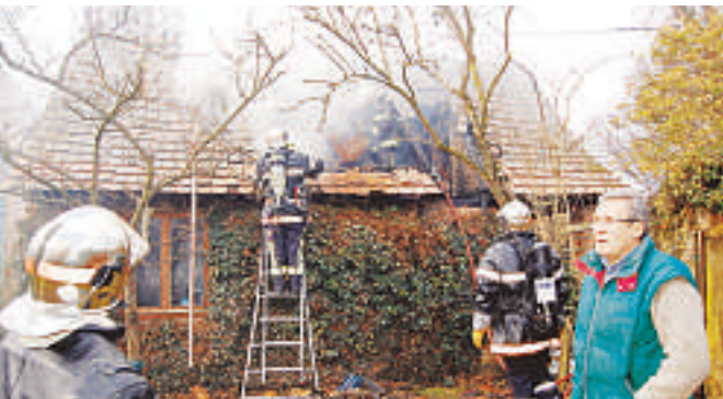
Les pompiers déblaient les combles pour éteindre le feu. (Photo DNA)
