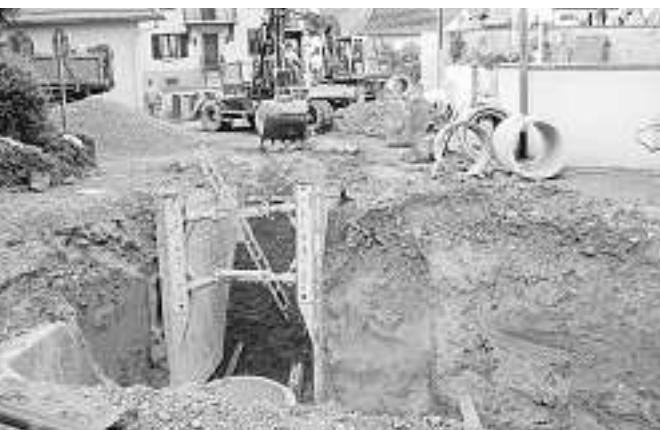
D'importants travaux d'assainissement. (Photo DNA)
